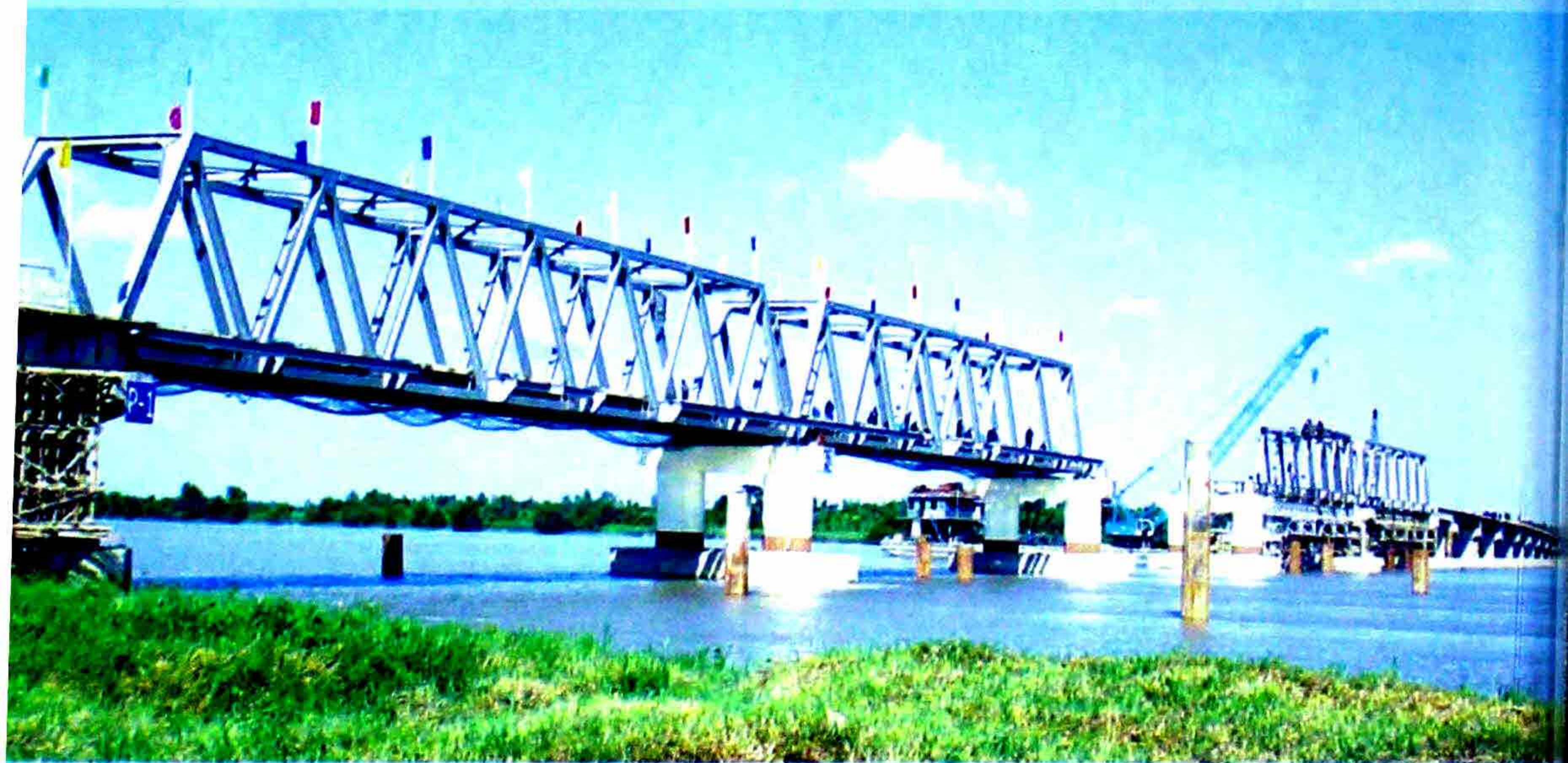
ရာဇုန်တံတားတည်ဆောက်မှုမြင်ကွင်း
