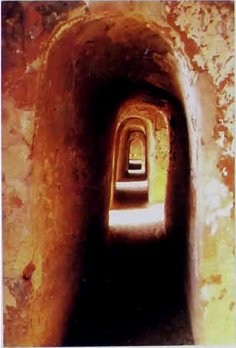
သမီးဝှက်ဥမင်လိုက်ဂူအတွင်းမှ စင်္ကြံလမ်းများကို တစ်ဆက်တည်းတွေ့မြင်ရပုံ
