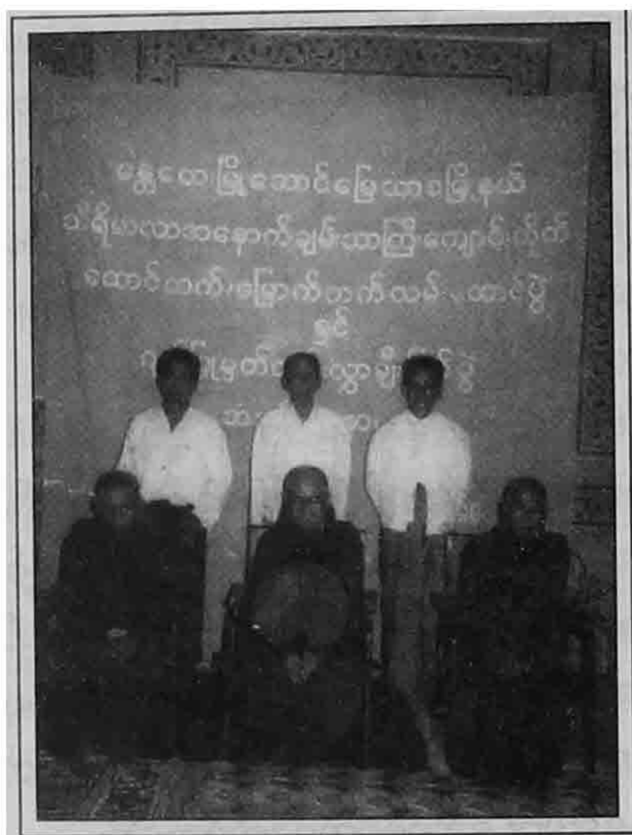
တိုက်တွင်းကတ္တရာလမ်း ဖြစ်မြောက်အောင်ဆောင်ရွက်စဉ်
